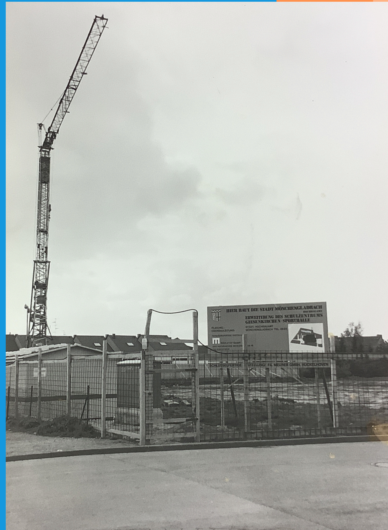
Bau der Mehrzweckhalle
